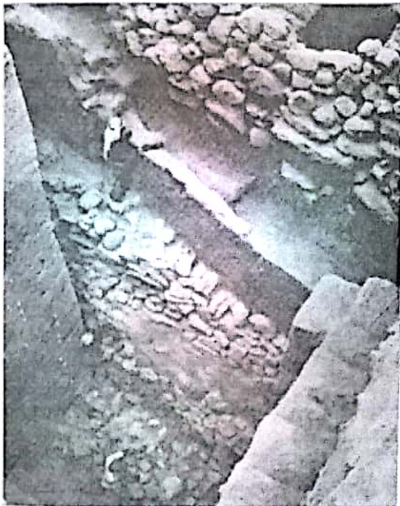
وینە ٢: وینە دیوارێک کە چەند جارێک چاکسازی بە خۆیوە بینیوە لە شاری جەرەش، چینه‌کانی بریتییه لە ریزە بەردی لەسەر یەك ھەلجراو.
